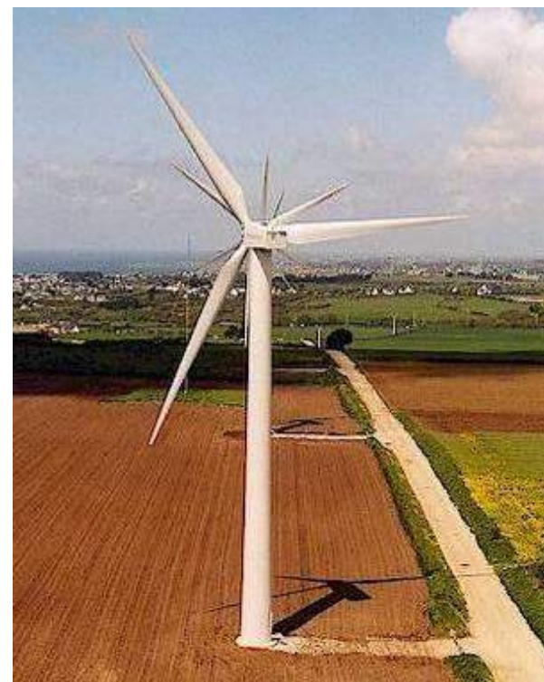
Photo 3 : Exemple de piste d'accès aux éoliennes
