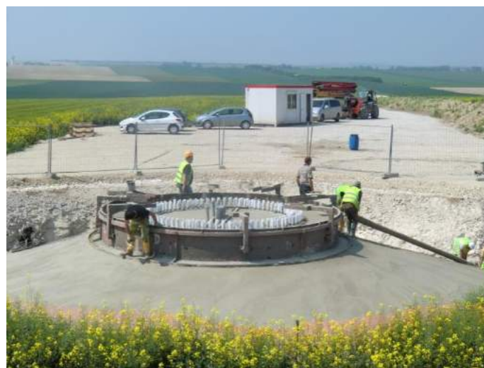
Photo 5 : Durcissement béton
