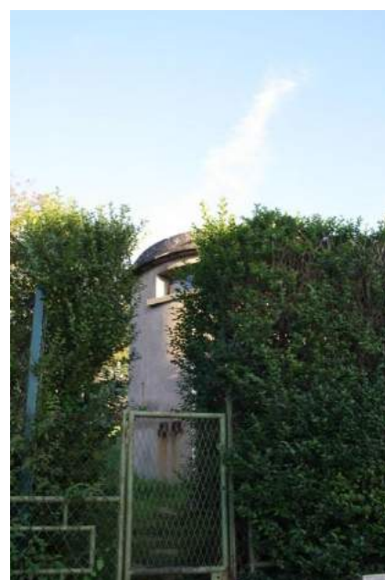
Photo 24 : captage AEP de Roôcourt-sur-la-Côte
