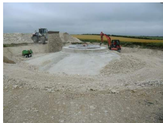
Photo 6 : Béton terminé et remblai
