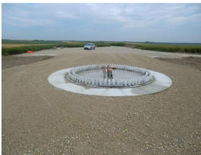
Photo 6 : Béton terminé et remblai
