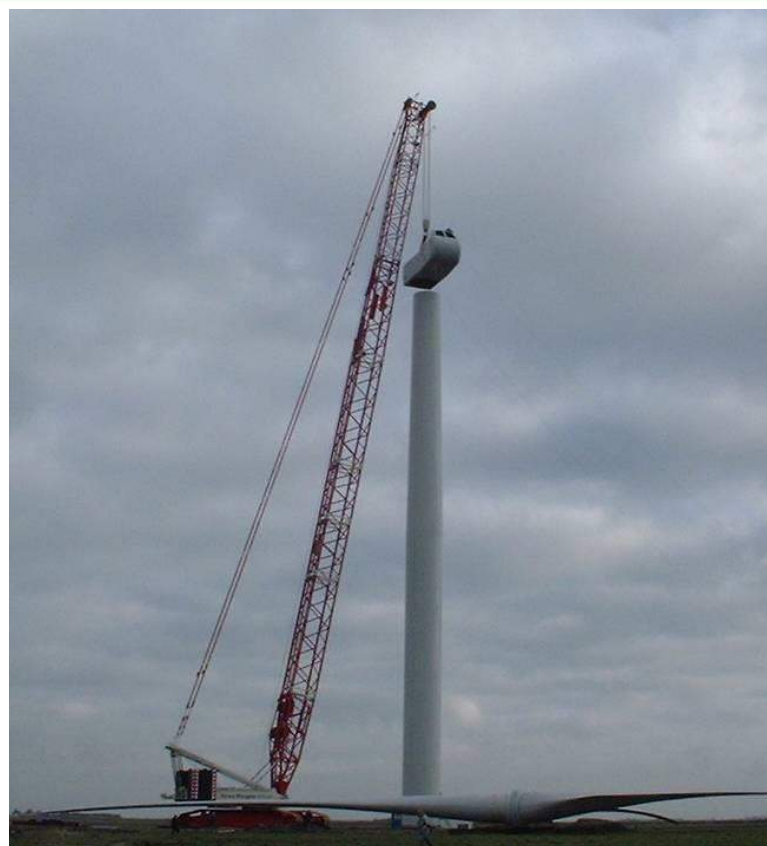
Photo 10 : Installation de la nacelle
