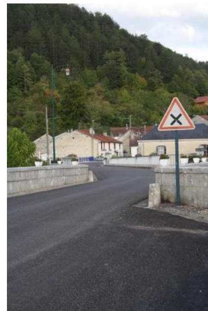
Photo 19 : Route communale sur Vouécourt
