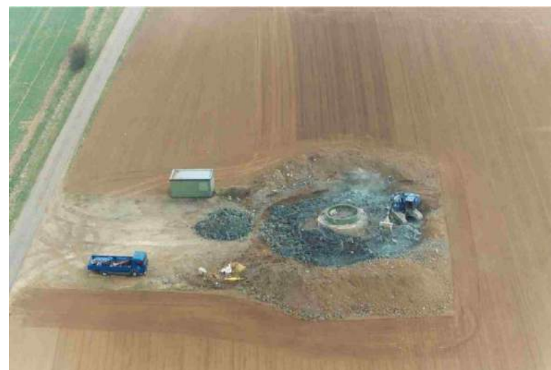
Photo 55: Exemple de démontage de la plate-forme et des fondations d'une éolienne
