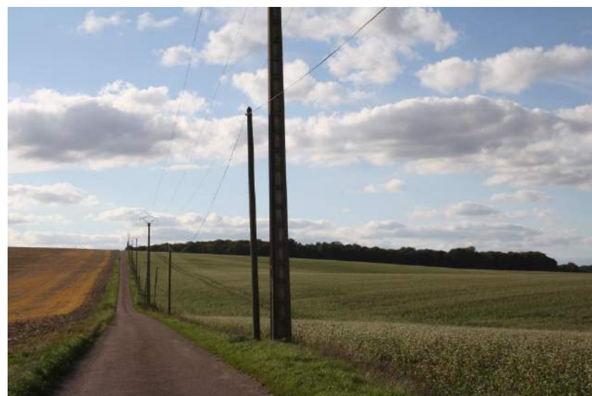
Photo 38 : Ligne ERDF sur la Z.I.P.
