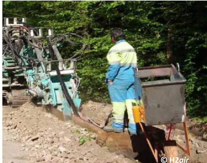
Photo 2 : Exemple de tranchées d'enfouissement du réseau électrique
